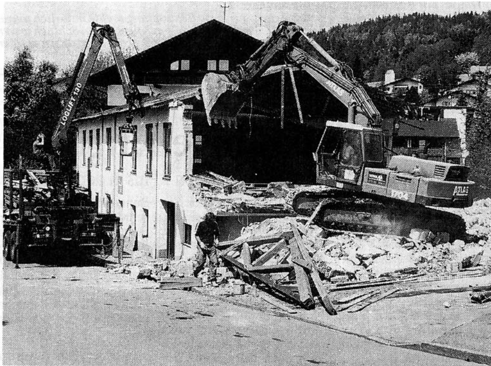
Ein Bagger frisst sich in das über hundert Jahre alte Gemäuer.
