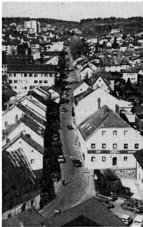
Die Bodenmaiser Straße ist neben der B 11 im Stadtbereich die meistbefahrene Ausfallstraße. (Foto: G. Hof)
