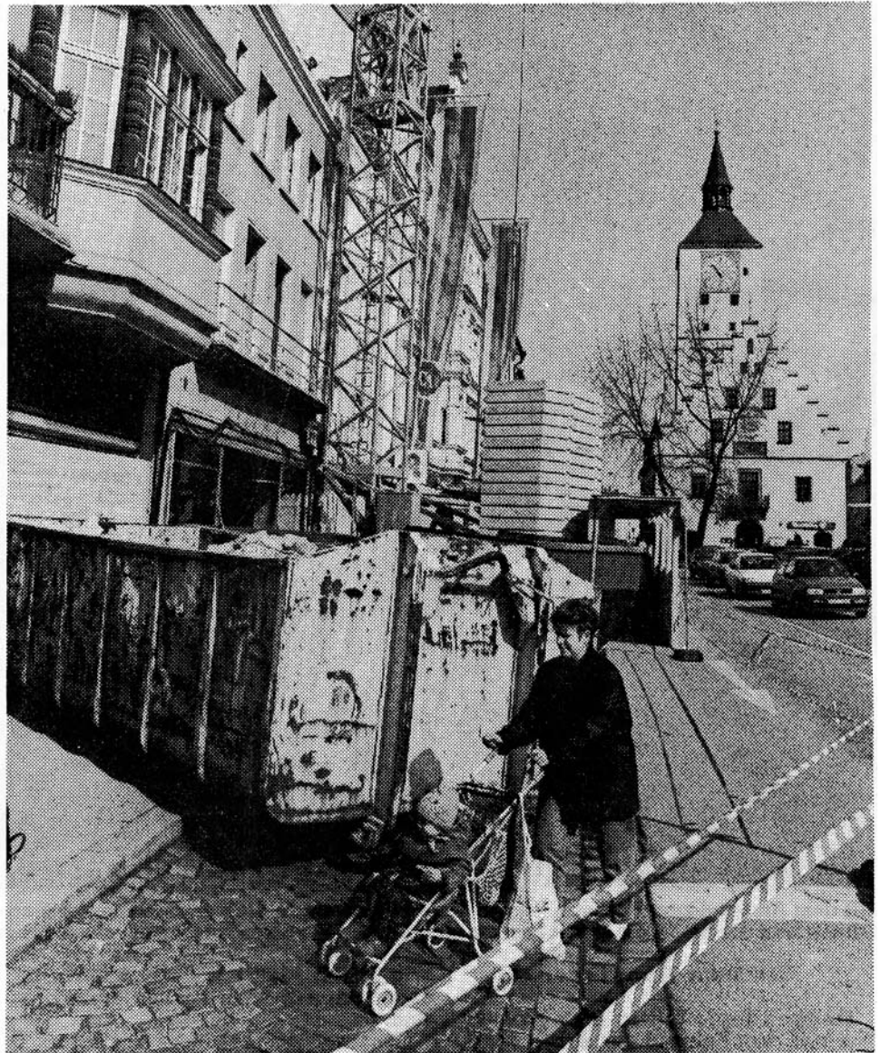
Die Fußgänger werden durch ein Holzdach geschützt. Behinderungen und Staubentwicklung sind beim Abriß des Falterhauses trotzdem nicht ausgeschlossen. (Frisch)
